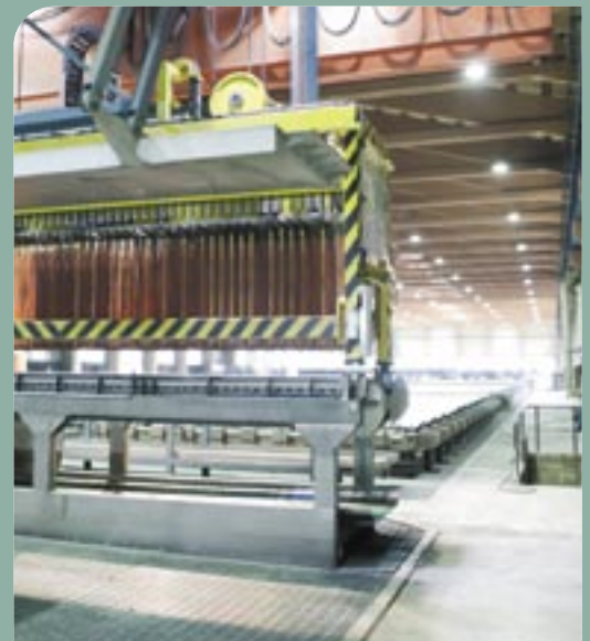
Die moderne Elektrolyse der Montanwerke Brixlegg AG
